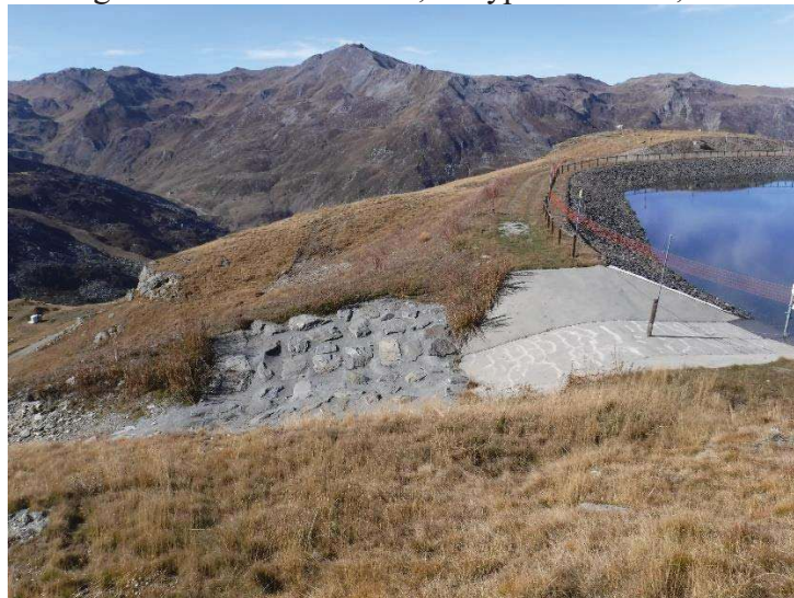
Figure 16 : Vue du déversoir au Sud-Est du lac
