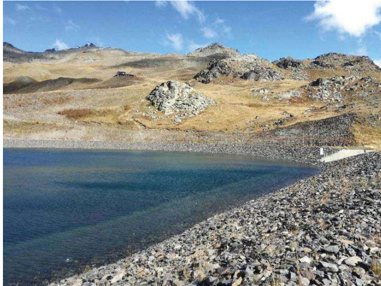
Figure 10 : Vue de la retenue en direction du Nord
