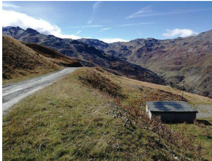
Figure 15 : Vue du cabanon de suivi de la retenue (chambre à vanne)
